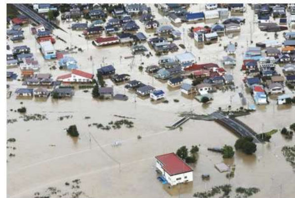
2019年台風19号による浸水被害（写真提供：共同通信社）
